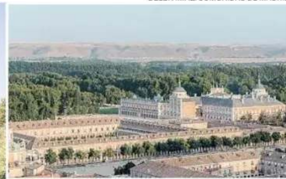
Vista del exterior del Palacio Real de Aranjuez
